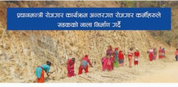
प्रधानमन्त्री रोजगार कार्यक्रम अन्तर्गत रोजगार कर्मीहरूले सडकको ढाला निर्माण गर्दै
