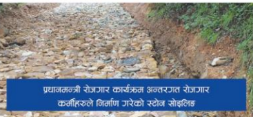
प्रधानमन्त्री रोजगार कार्यक्रम अन्तर्गत रोजगार कर्मीहरूले निर्माण गरेको स्टोन सोडलिङ
